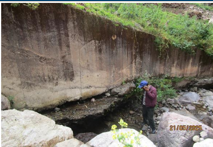
FOTOGRAFIA N° 01: MARGEN IZQUIERDA SOCAVADA, COLMATADO EL CAUCE DE LA QUEBRADA
