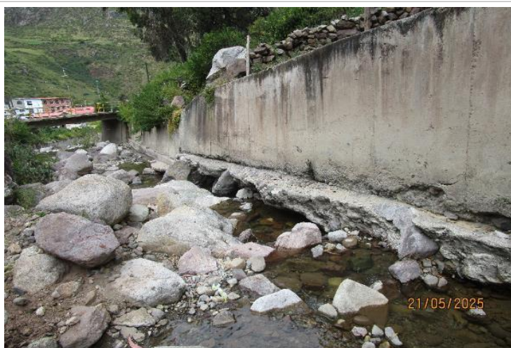
FOTOGRAFIA N° 03: CAUCE DE LA QUEBRADA COLMATADO CON PIEDRAS, ARENA Y GRAVAS ASI MISMO SE PARECIA SOCAVACION .
